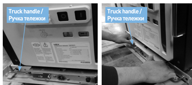
Fig. 4-10 Withdrawing of the G/M Type / Рис. 4-10 Выкатывание типа G/M (2)
