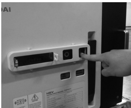
Fig. 3-4 Close operation / Рис. 3-4 Операция замыкания
