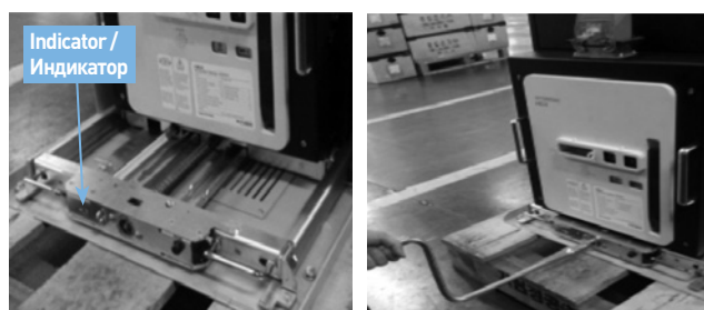
Fig. 4-9 Insertion of the G/M Type (2) / Рис. 4-9 Установка типа G/M (2)
