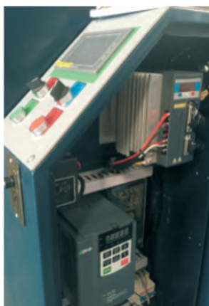
Автомат по резке резины
