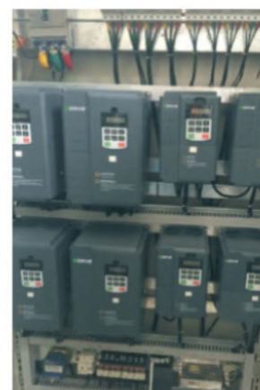
Система очистки воды
